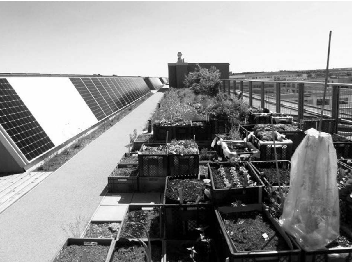
Dachterrasse mit Garten, RIO, München-Riem, Architekten Zwingel und Dilg
