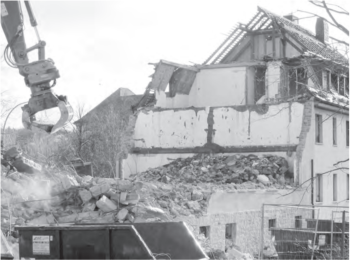
Abriß der Gebäude Wittelsbacher Straße 13-17 im Januar 2024, im Hintergrund nördlicher Pavillon des Instituts für Lehrerbildung der Universität Würzburg.
